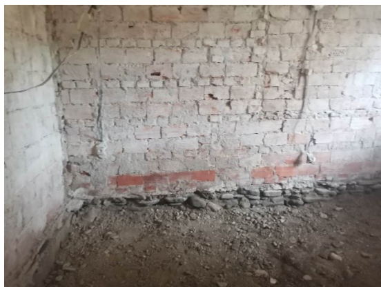
Slika 3: Kamniti temelji, krušni zidovi.
