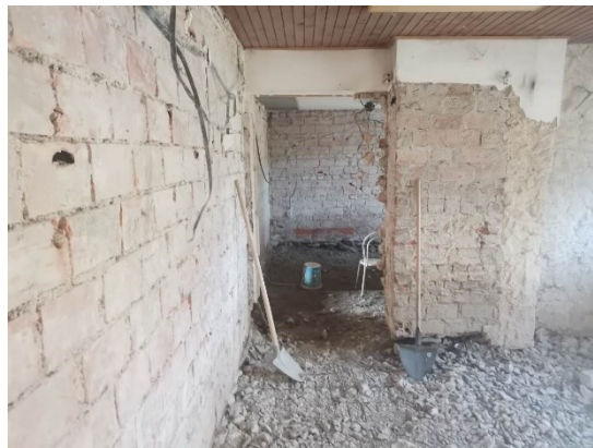
Slika 2: Notranjost objekta; odstranjeni ometi in tlak (vidni kamniti temelj na koncu zidu)
