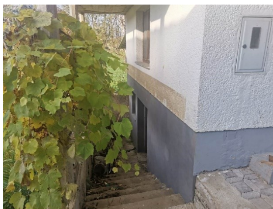
Slika 4: Južna fasada gospodarskega objekta - vidna linija vode na fasadi
